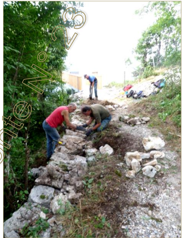
Restauration et raccordement des murets à la plateforme
