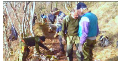
Tous les mercredis, les bénévoles s'affairent à diverses tâches comme la réfection et la construction de bordures et de murets ou encore l'élargissement du sentier.
